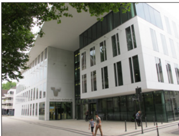
Volksbank Krefeld mit Fassade aus Nanodur-Beton
