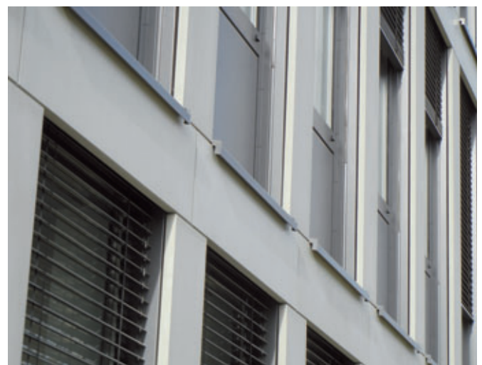
Bürogebäude Ferchau, Fugenausbildung
