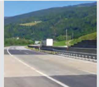
Brückenerüchtigung, TU Graz
